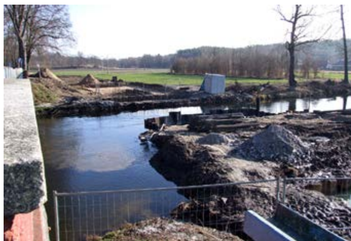
Obra częściowo zagrodzona, prace przy budowie mostu w Bledzewie trwają
