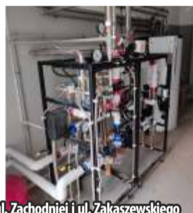
Montaż węzłów ciepłych przy ul. Zachodniej i ul. Zakaszewskiego
