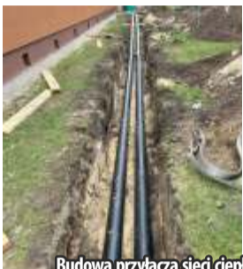
Budowa przyłącza sieci ciepłowniczej do ulicy Głowackiego
