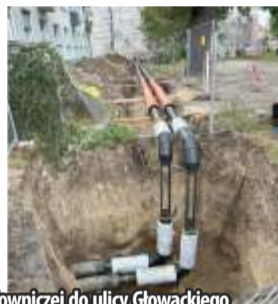
Budowa przyłącza sieci ciepłowniczej do ulicy Głowackiego
