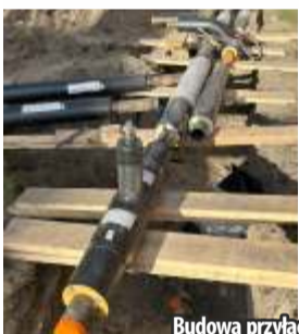
Budowa przyłączy ciepłowniczych
