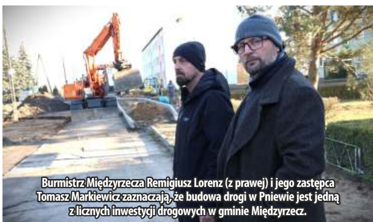
Finał prac przewidziano na koniec września br.
